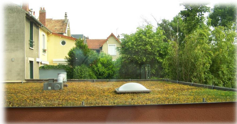
Toiture végétale - services techniques Le Perreux
