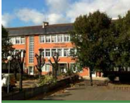
GRUPE SCOLAIRE ANATOLE FRANCE – JEAN ROSTAND À STAINS
