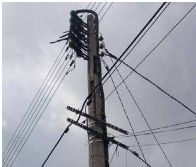
Les réseaux en fil nu, constitués de fils de cuivre non isolés, sont devenus vétustes.
