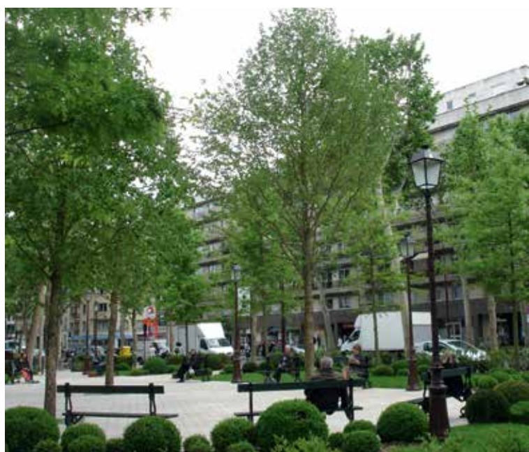
Des travaux de modernisation de l'éclairage public ont été réalisés en mai 2013 sur la place Saint-Foy à Neuilly-sur-Seine.
