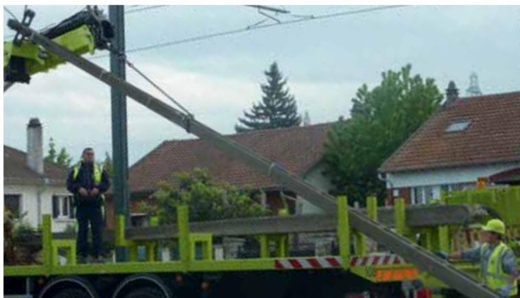
Travaux d'enfouissement des réseaux de distribution publique d'électricité à Villetaneuse.
