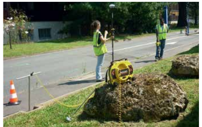
La détection des réseaux souterrains permet d'obtenir des plans d'une grande précision.
