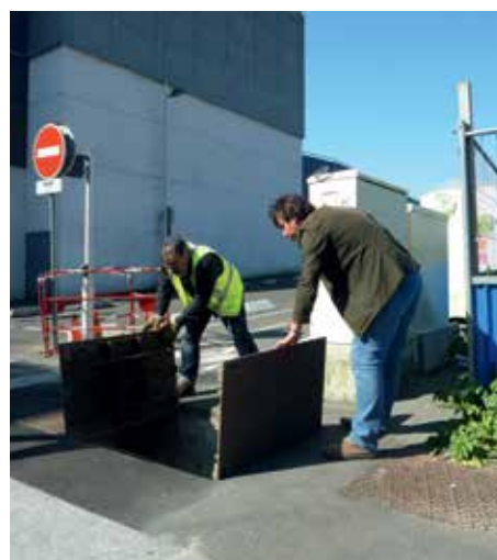
Interventions sur le réseau de fibre optique IRISÉ.
