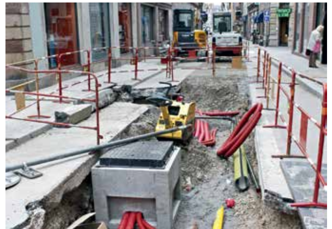
Travaux sur les réseaux souterrains.
