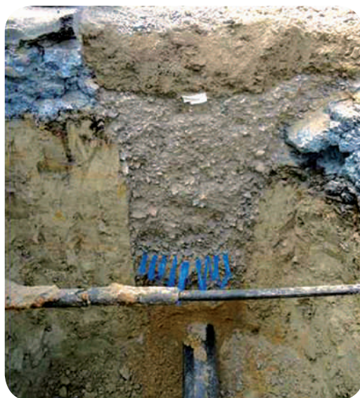
Renouvellement en technique traditionnelle à Montfermeil (ouverture en tranchée)
