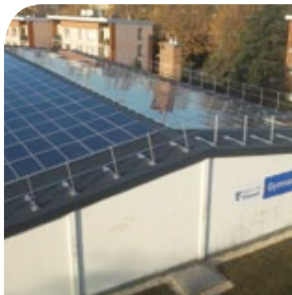
Clamart : Gymnase Bretagne
