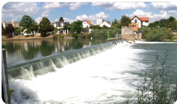
Figure 4 : Barrage de Joinville
