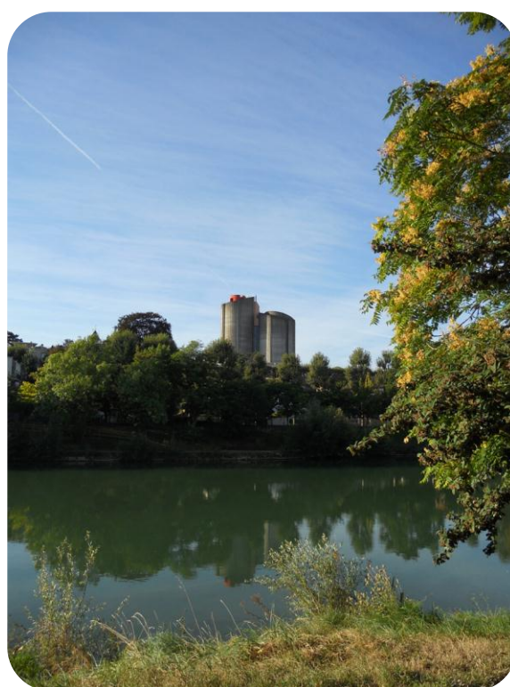
Figure 22 : L'usine de production d'eau potable de Saint-Maur
