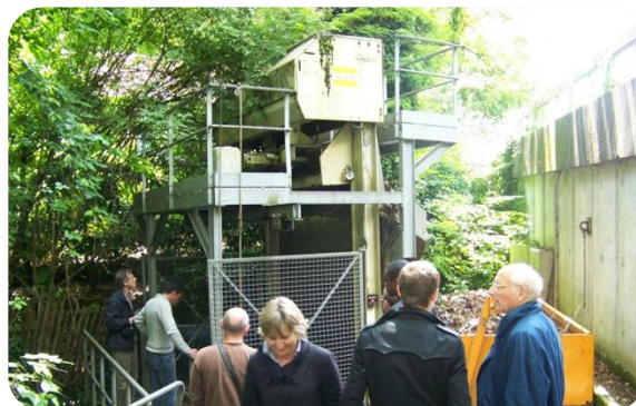
Figure 24 : Visite de terrain Bras de Gravelle
