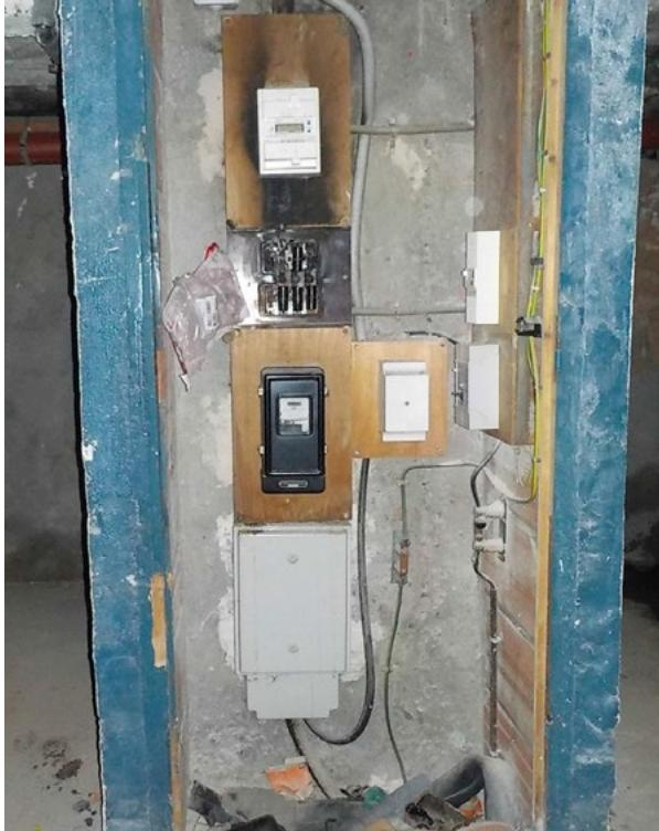
AVANT : exemple de coffret de coupure de colonne, dont les pièces sous tension sont directement accessibles, et sur laquelle un départ d'incendie s'est présenté.
