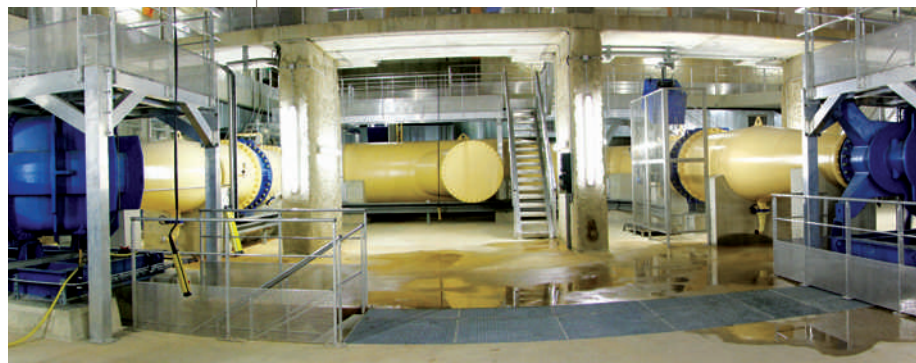
Réalisation du niveau R0 avec les trois tours d'équilibre à l'aspiration des pompes et l'emplacement des 5 réservoirs antibélier à leur refoulement
