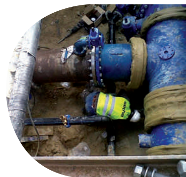
Raccordement du bief 31 sur le bief 26 sous la RN 3 à Bondy
