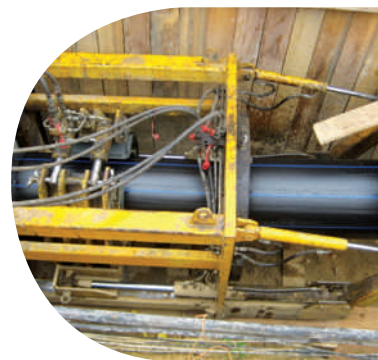
Dispositif d'insertion de canalisation et de réduction de diamètre
