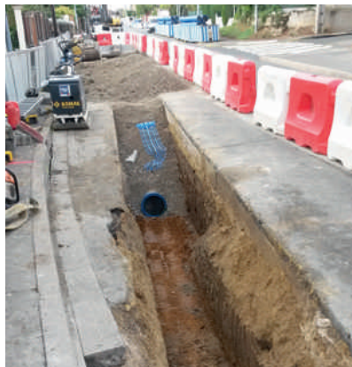
ATHIS-MONS, AVENUE JULES VALLÈS, 1 450 ML EN FONTE DUCTILE DE DIAMÈTRE 300 MM, DURÉE 1 AN
