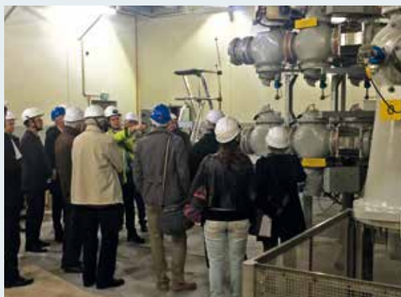
Visite des élus et des services du Sigeif, en novembre 2015, au poste Boule, à Nanterre.
