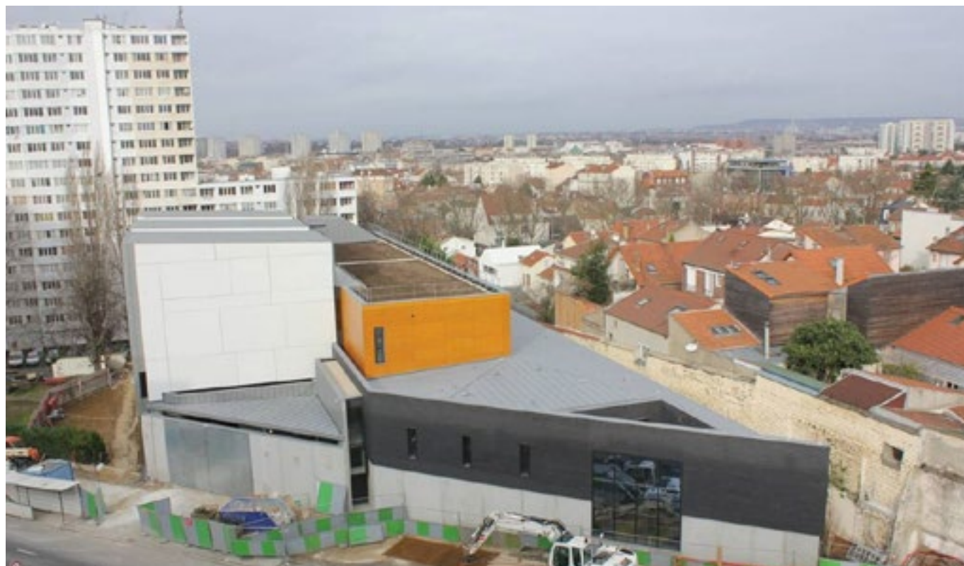
Poste source Boule de Nanterre.
