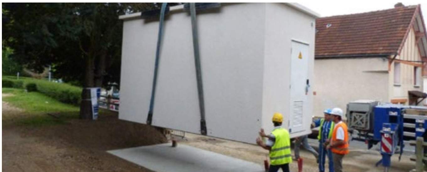
Installation du point de mutualisation à Villiers-sur-Orge.
