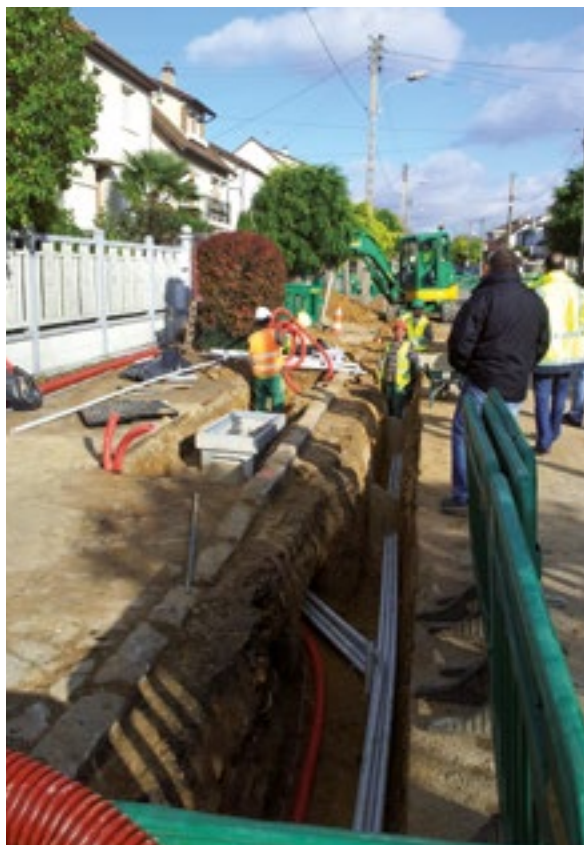
Un chantier d'enfouissement à Chevilly-Larue. La ville a enfoui la totalité de son réseau en 2014 grâce à l'appui du SIPPAREC.
