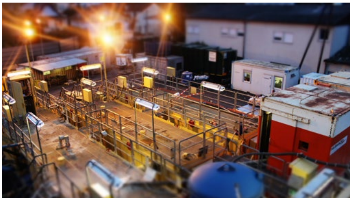
Plateforme de forage géothermique.
