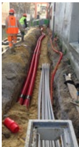
Pose de réseaux mutualisés à Saint-Denis.
