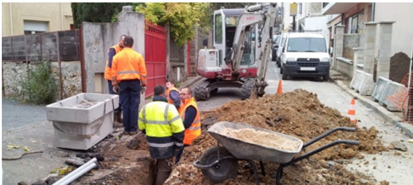
Travaux d'installation du très haut débit à Epinay-sur-Orge
