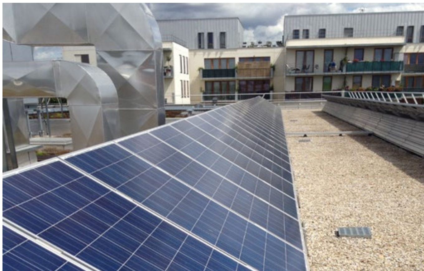
École Jean Jaurès à Valenton - Puissance installée de 17 kWc, production d'électricité 15 800 kWh/an, quantité de CO 2 évitée : 1,4 tonne/an.
