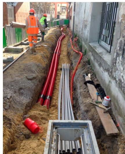
Pose de réseaux mutualisés à Saint-Denis.
