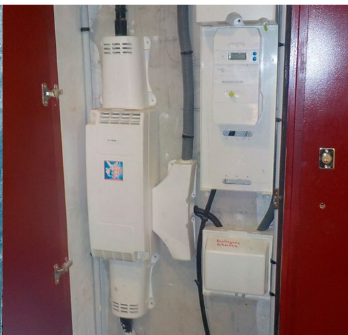
APRÈS : Exemple d'une colonne montante rénovée.
