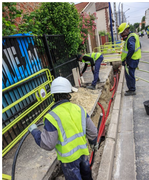
Les travaux d'enfouissement à Drancy
