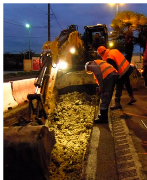
Travaux de terrassement de nuit à Rosny-sous-Bois.
