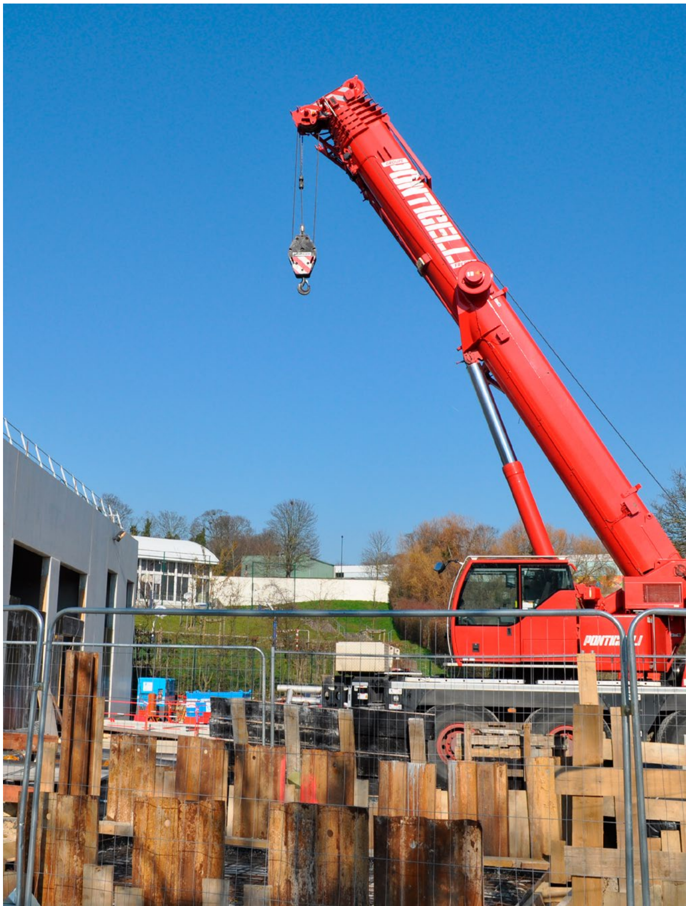
Construction de la centrale de géothermie à Bagneux
