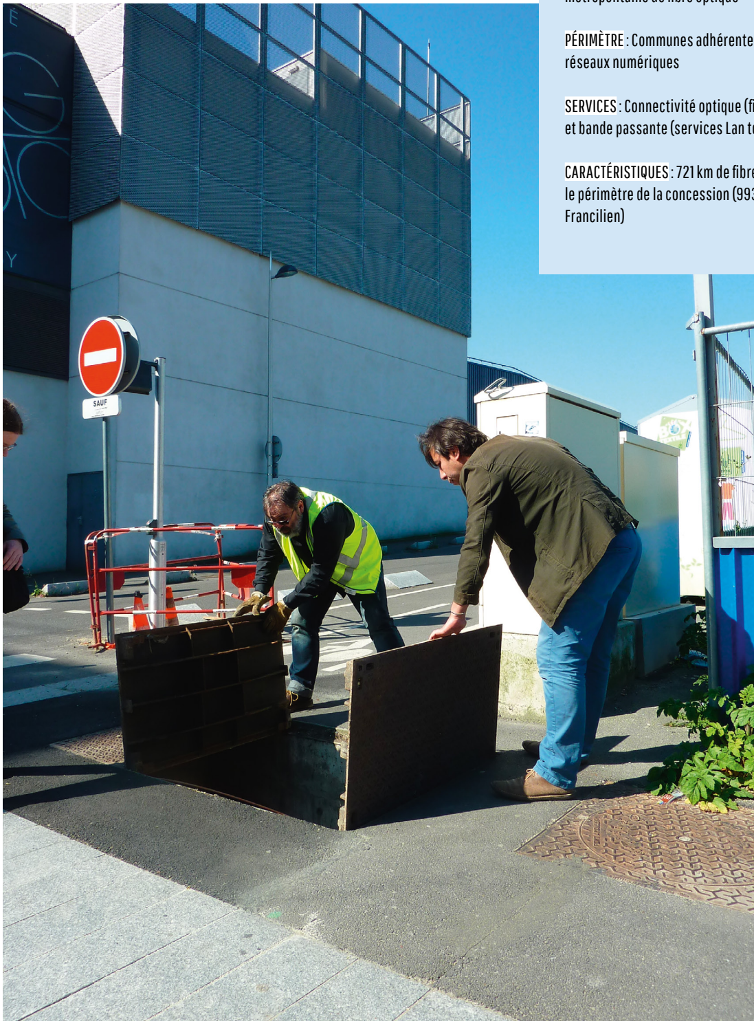
Installation du réseau IRISÉ
