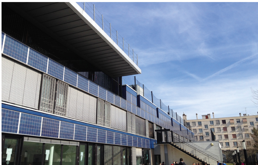
Les panneaux solaires installés en façade de l'école élémentaire Jean-Louis Marquèze, à Limeil-Brévannes.
