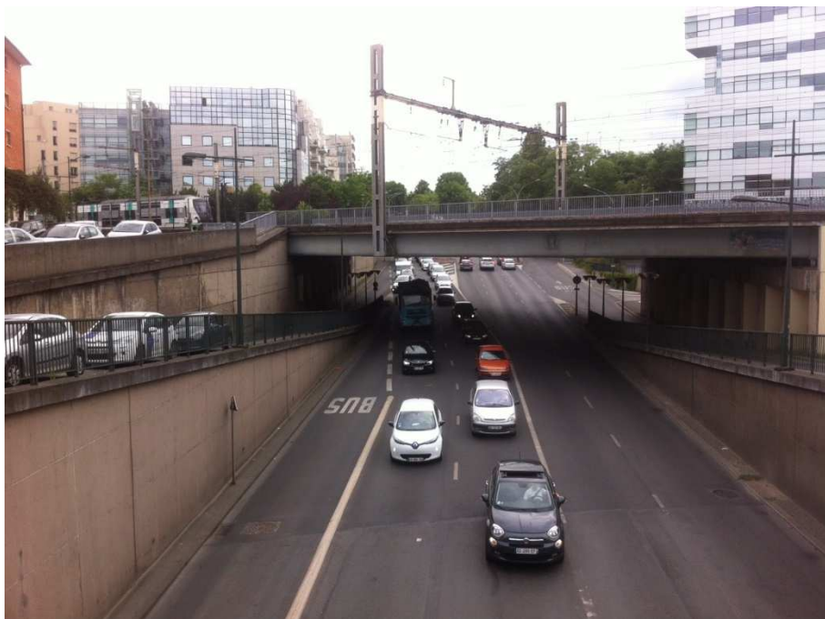
Figure 3.6 : la coupure urbaine de la RD4 en tranchée devant la gare de Joinville-le-Pont
