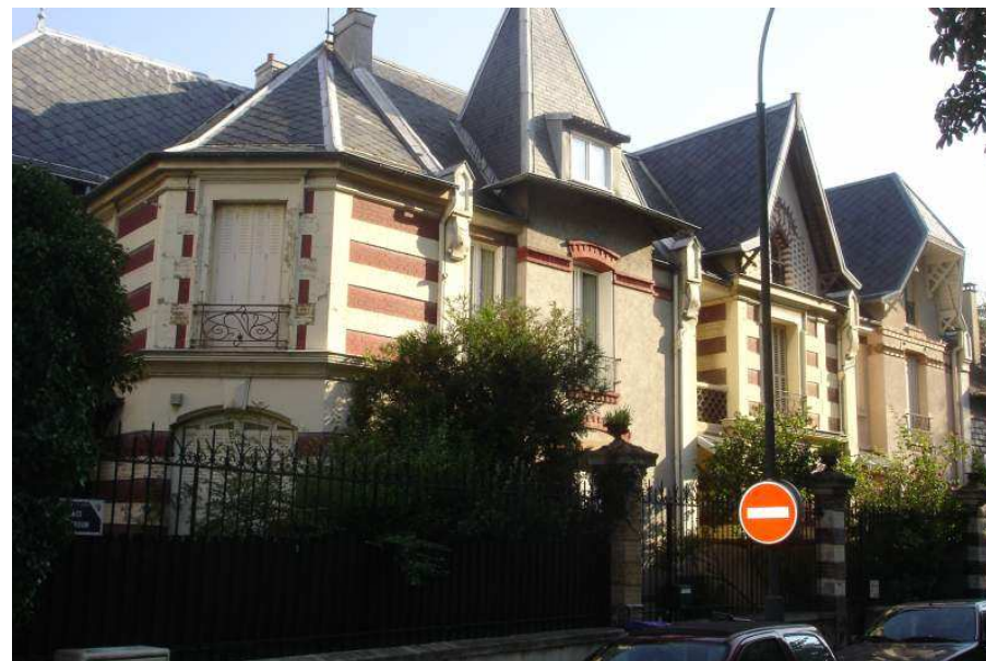
Figure 15 : photographie de constructions remarquables quartier Polangis
