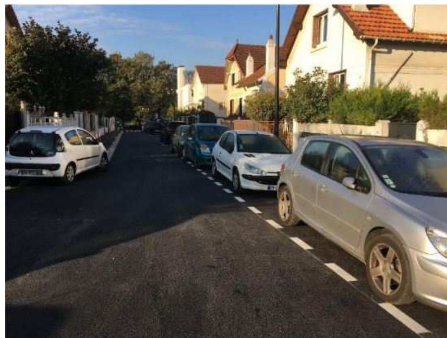
Figure 3.11 : une rue de la zone pavillonnaire de Palissy
