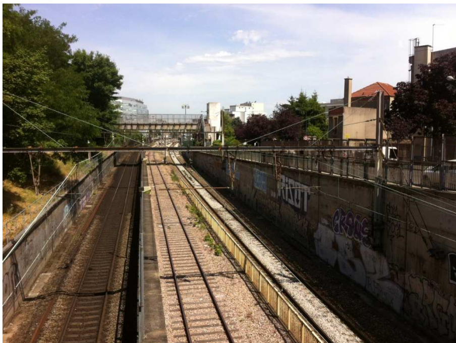
Figure 23 : photographie de la rupture écologique constituée par les voies du RER A en tranchée (quartier des Hauts-de-Joinville)
