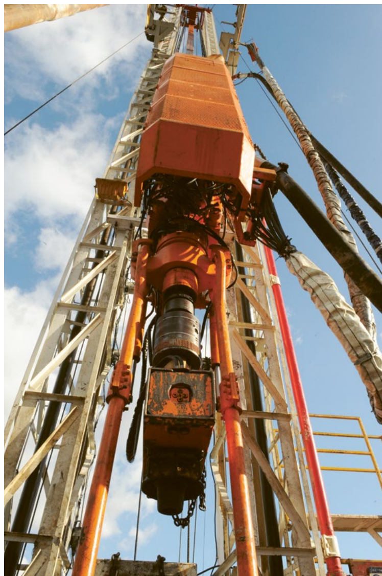
Machine de forage de géothermie.
