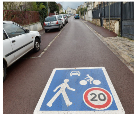
Marquage au sol signalant une zone de rencontre Crédits photo : Thierry GOUGENOT
