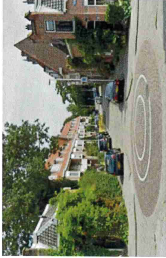
Ralentisseur circulaire bombé, Utrecht, Pays-Bas Credit: photo: l'arsenicelle.fr
