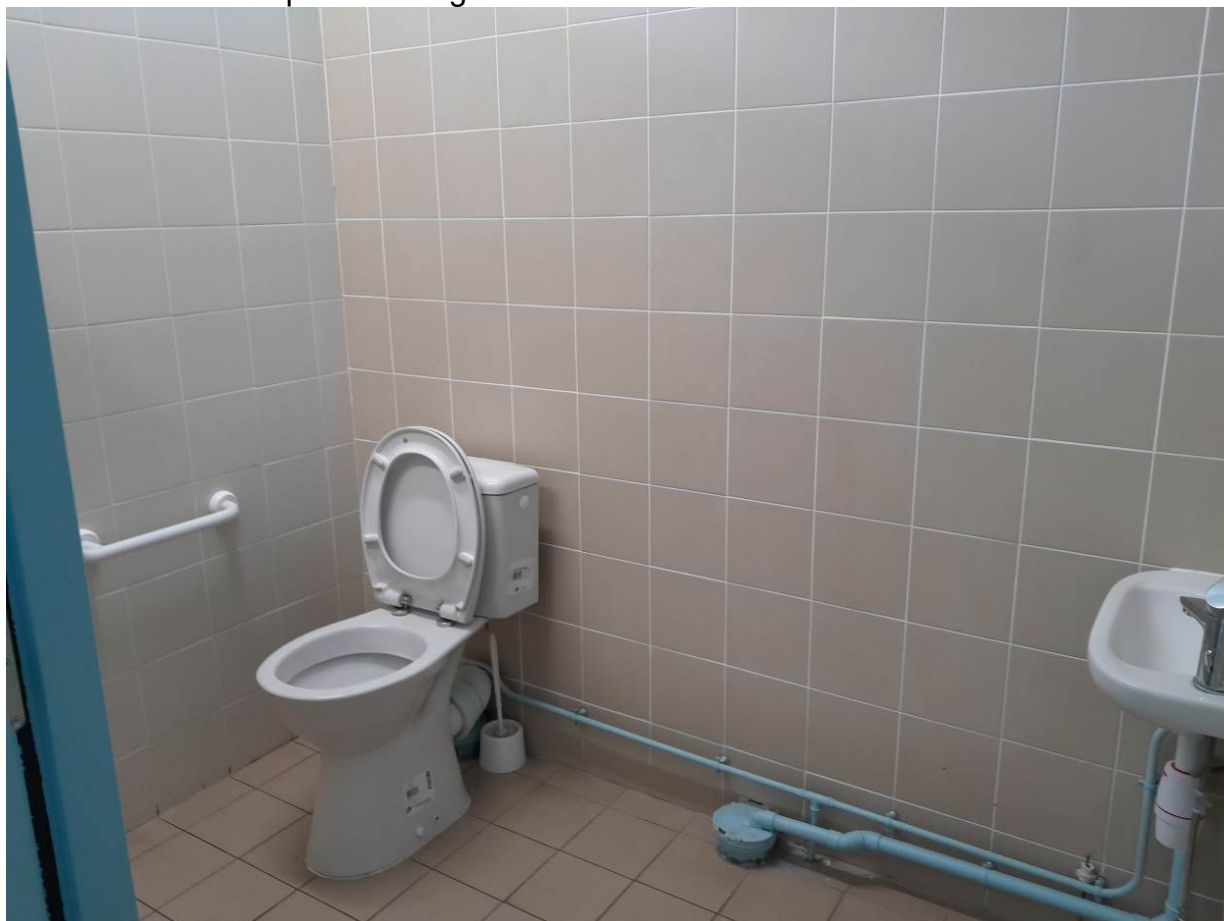
Toilette PMR école primaire Eugène Voisin
