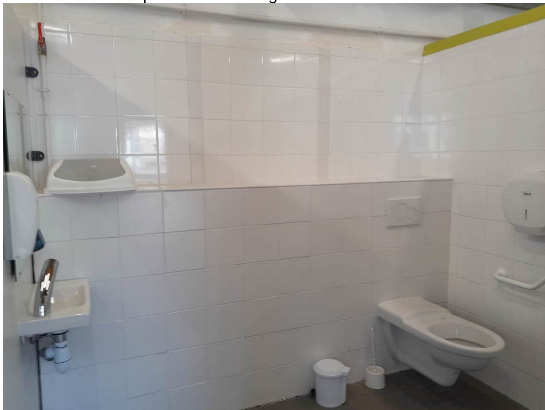
Toilette PMR école primaire de Polangis
