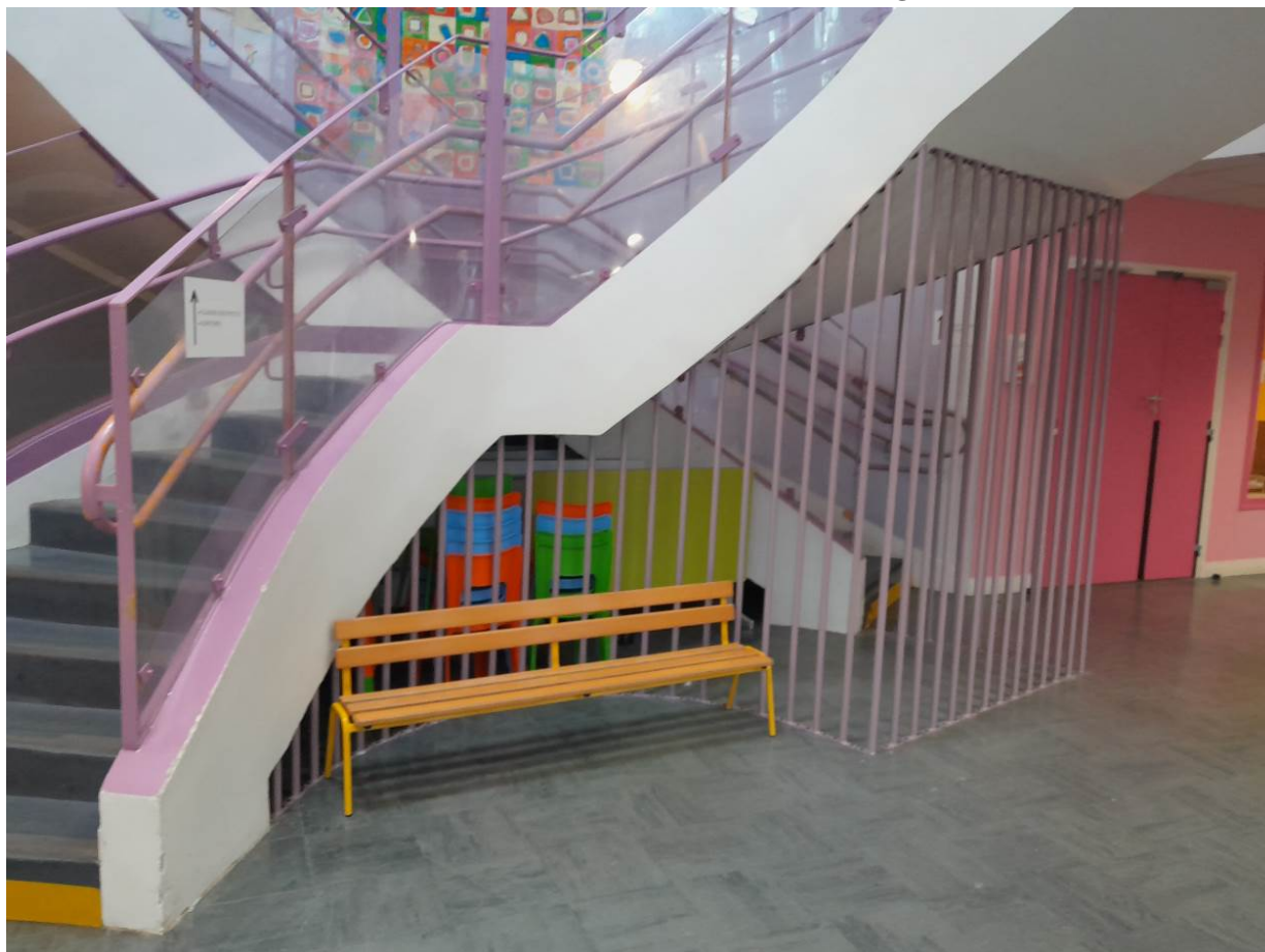
Sécurisation sous-bassement escalier école maternelle P'tit Gibus
